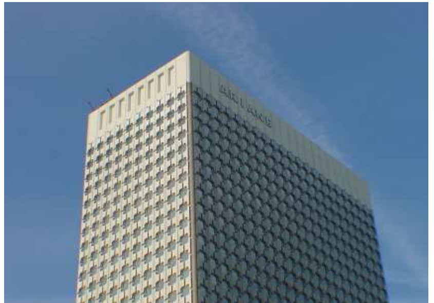
état préexistant : couronnement de la tour
