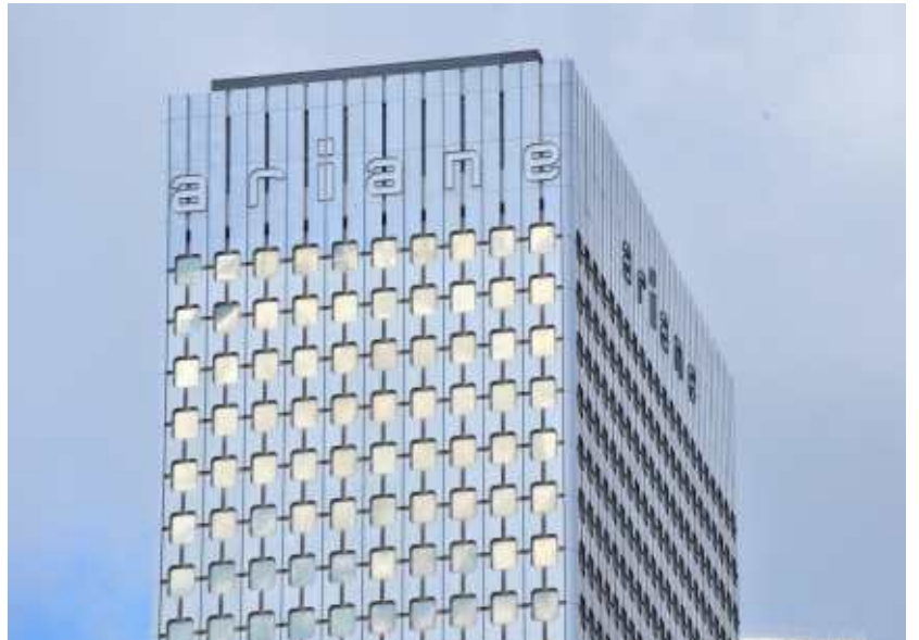
enseigne façades nord et est
