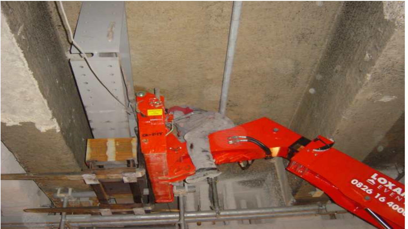
renforcement pour reprise portiques
