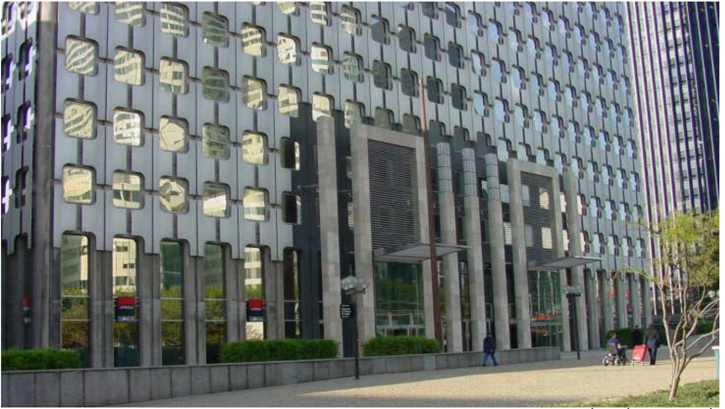
état préexistant : entrée
