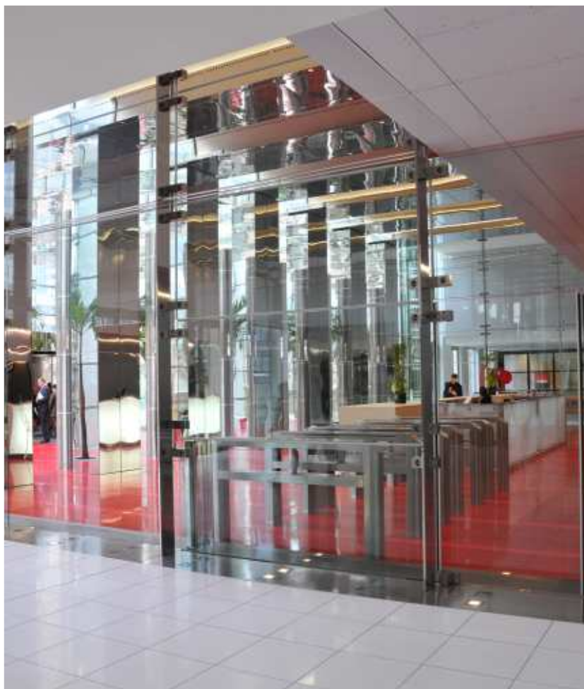
façade intérieure ouest
