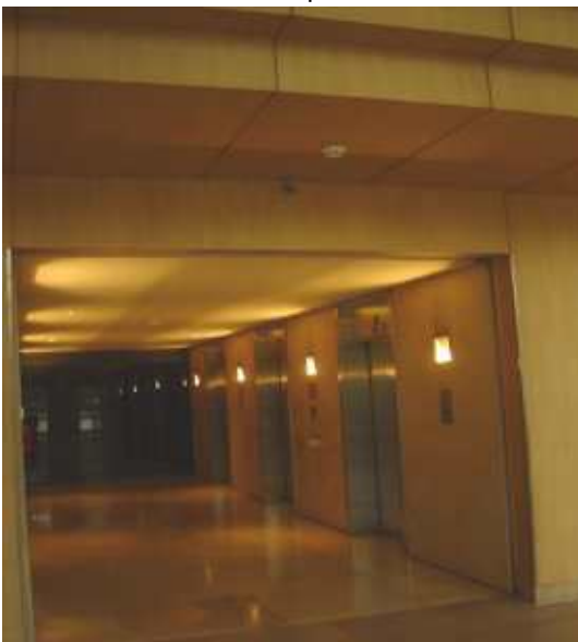
état préexistant : ascenseurs
