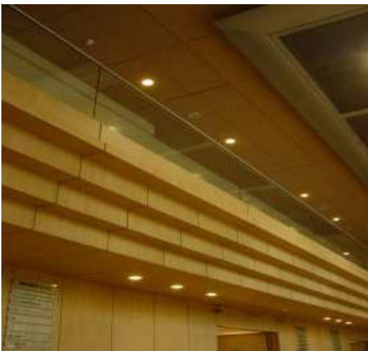
état préexistant : mezzanine
